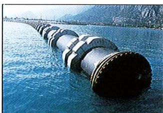
Avloppsledning Antalya, Turkiet, 1997, storlek 1600 mm, längd 5401 m.
