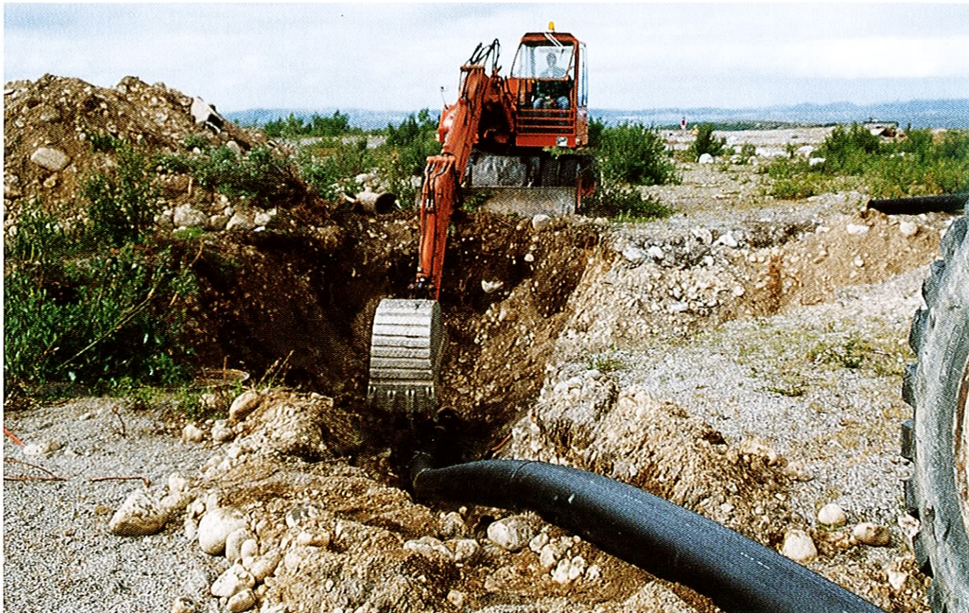
Bild 2.4.A Relining med PE-rör
