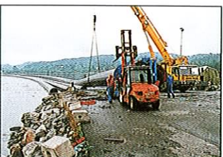
Avloppsledning Tay, Skottland, 1999, storlek 1600 och 1100 mm, längd 1606 m.
