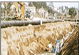
Val do Ave, Portugal, avloppsledning, 1993, storlek 900 och 1000 mm, längd 4000 m.
