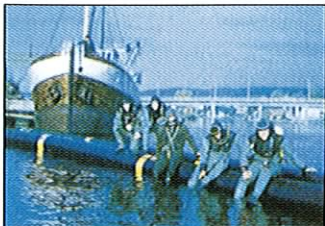
Avloppsledning Sola kommun, Norge, 1961-62, storlek 600 mm, längd 250 m.
