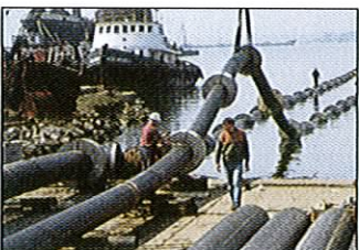
Dricksvattenledning till Prince's Islands, Istanbul, Turkiet, 1996, storlek 630 och 450 mm, längd 1200 m.
