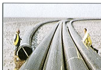
Utloppsledning, Middleton, Morecambe, Storbritannien, 1996, storlek 800 mm, längd 2400 m.
