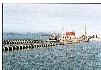
Avloppsledning Santander, Spanien. 1999, storlek 1400 mm, längd 2690.
