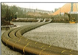
Kylvattenledning Mönsterås Bruk, Sverige, 1998, storlek 1000 mm, längd 5100 m.
